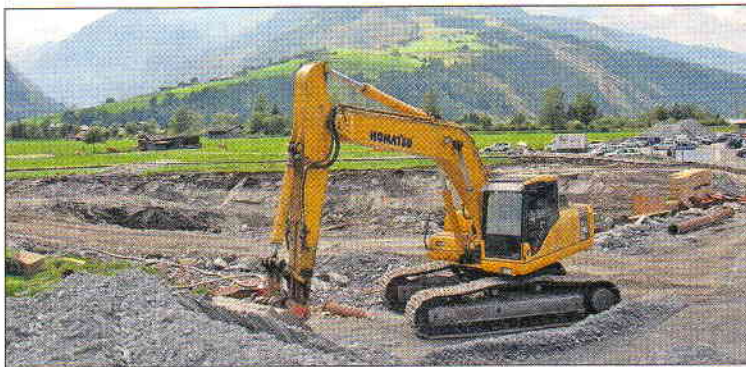
Nachdem die Finanzierungsfrage geklärt worden war, konnte kürzlich mit dem Bau der „Tauern SPA World“ in Kaprun begonnen werden. Teil des Projekts ist die Errichtung eines Hotels der gehobenen 4-Sterne-Kategorie mit insgesamt 320 Betten.
